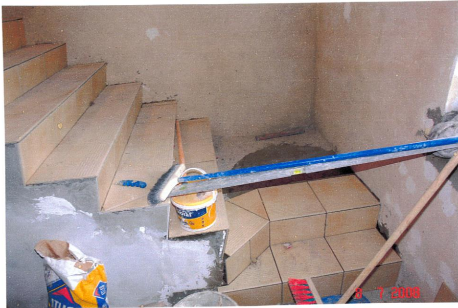
SCHODY DO POMIESZCZENIA NAD ZAKRYSIĄ.
