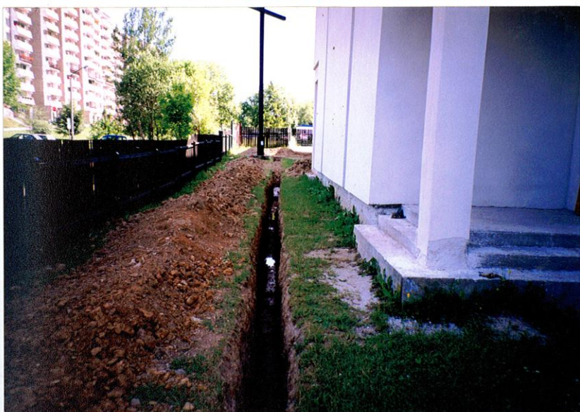
INSTALACJE ODPROWADZAJĄCE WODY DESZCZOWE.
