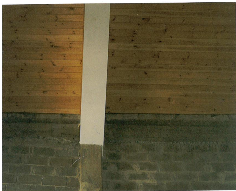
WYCINEK ZABUDOWANEGO SUFITU
