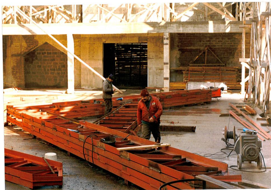
STALOWE ELEMENTY KONSTRUKCJI DACHOWEJ.
