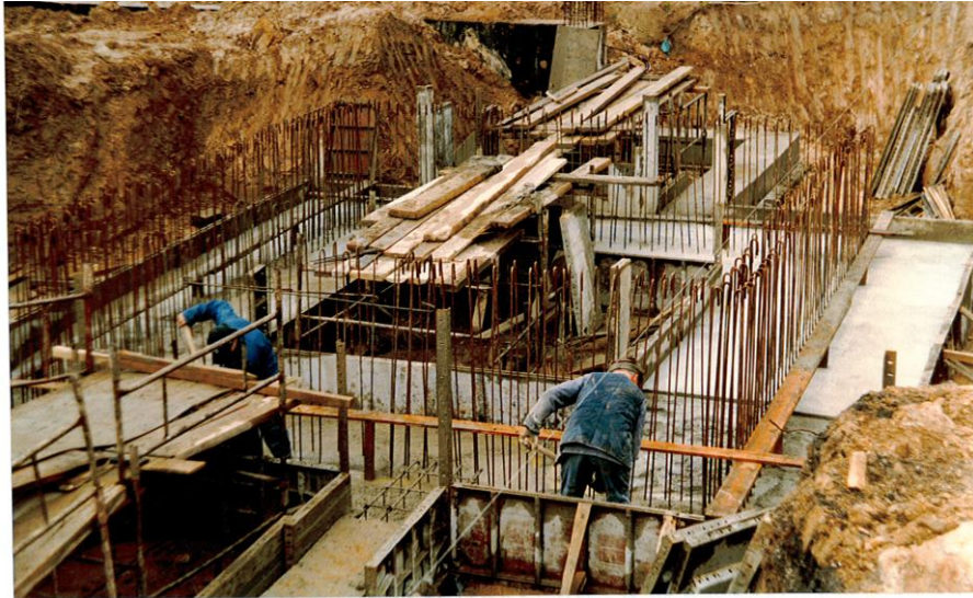
FUNDAMENTY POD WIEŻĘ
