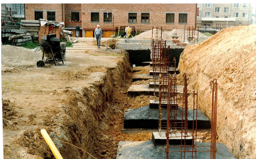
FUNDAMENTY POD SŁUPY NOŚNE
