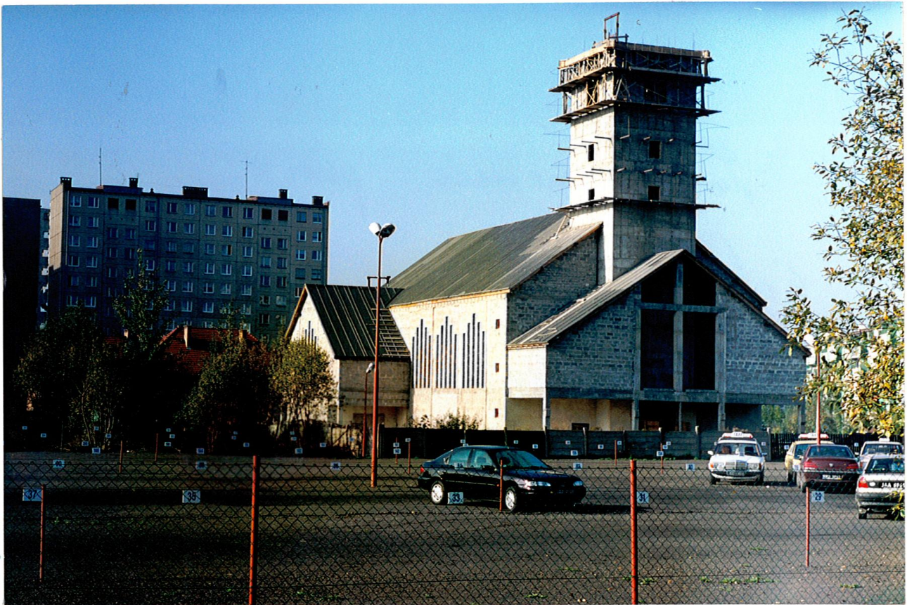
ZAKOŃCZENIE PRAC ŻELBETOWYCH PRZY WZNOSZENIU WIEŻY KOŚCIOŁA.
