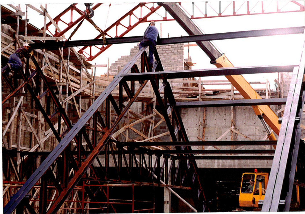
KONSTRUKCJA DACHOWĄ MONTOWANA WENNAŁRZ KOŚCIOŁA.
