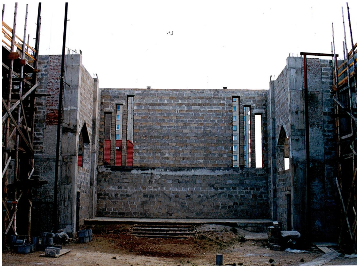
MURY KOŚCIOŁA W OCZEKIWANIU NA DACH
