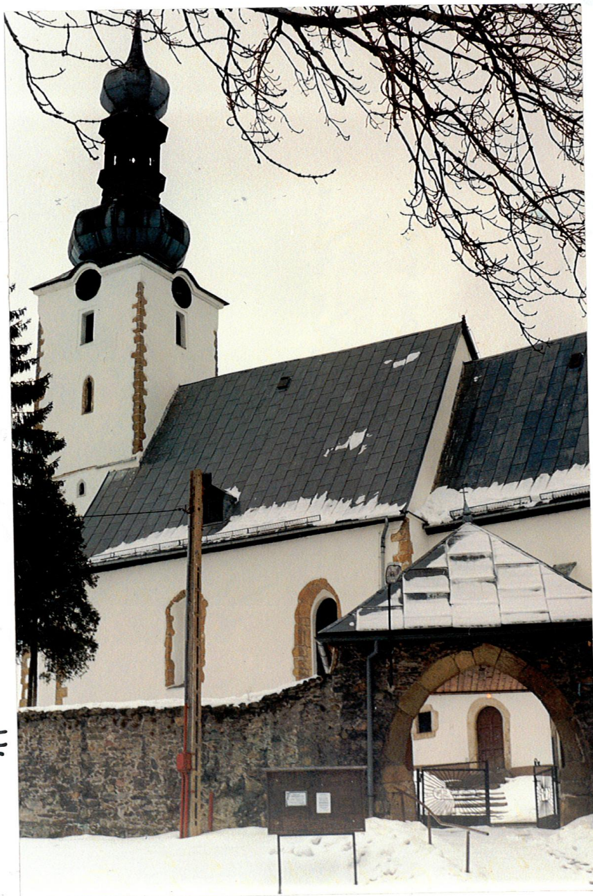
KOŚCIÓŁ W DZIWISZOWIE PO REMONCIE DACHU I ELEWACJI
