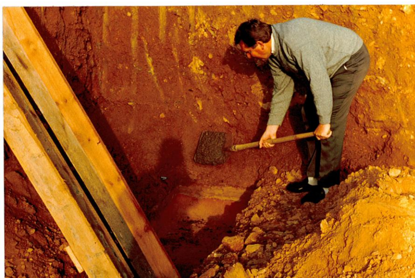
PIERWSZA ŁOPATA BETONU POD FUNDAMENTY KOŚCIOŁA
