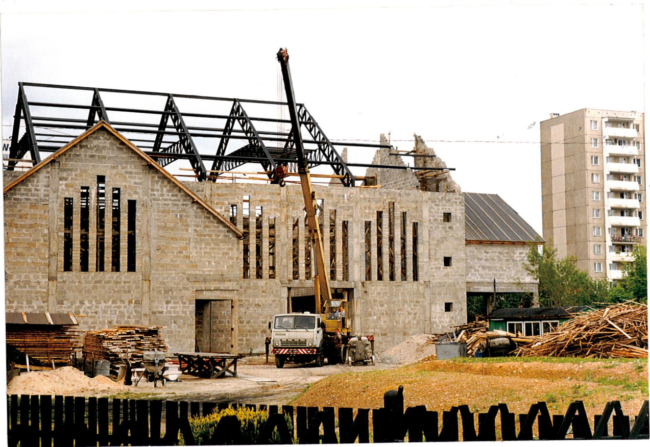
KONSTRUKCJA DACHOWA UMIESZCZONA NA FILARACH NOSNYCH.
